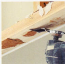
扉上部の剥がし作業
